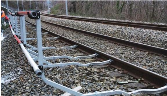
Ce type de dispositif est constitué d'un ensemble d'éléments rigides installés sur la voie circulée et dont la distance entre le rail et l'extrémité du montant vertical de la barrière est réglable en profondeur selon la distance de la zone dangereuse.
