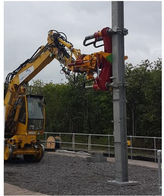
Le manipulateur SM15 a été conçu pour la manutention et l'installation de poteaux caténaire, pour un fonctionnement **en toute sécurité**.
