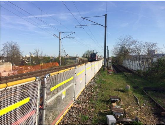
La barrière défensive est constituée d'un ensemble d'éléments rigides et d'écrans installés sur la voie circulée et dont la distance entre le rail et l'extrémité du montant vertical de la barrière est réglable en profondeur.
