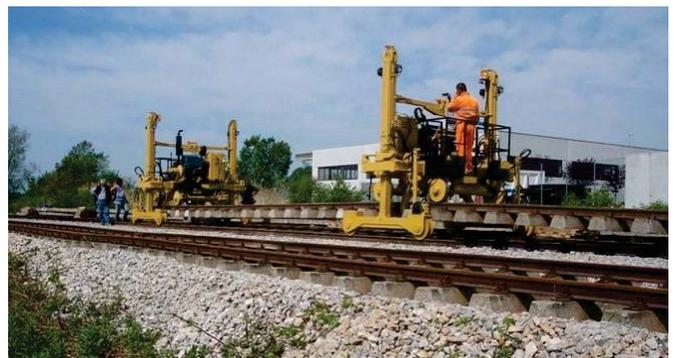
La mise en place par ripage latéral est exécutée à l'aide de caissons montés sur les pieds du portique. La mise en place de façon longitudinale est exécutée avec des lorrys sur rails auxiliaires ou des caissons équipés de roues montés sur la machine.
