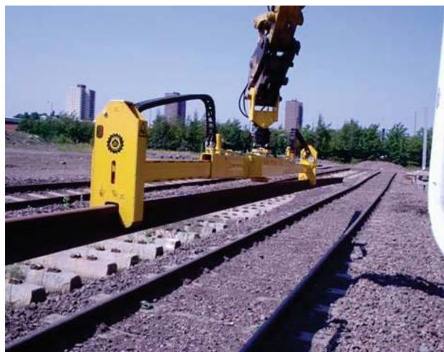
Ce palonnier télescopique à rails est destiné à la manutention de rails élémentaires jusqu'à 20m de longueur.
